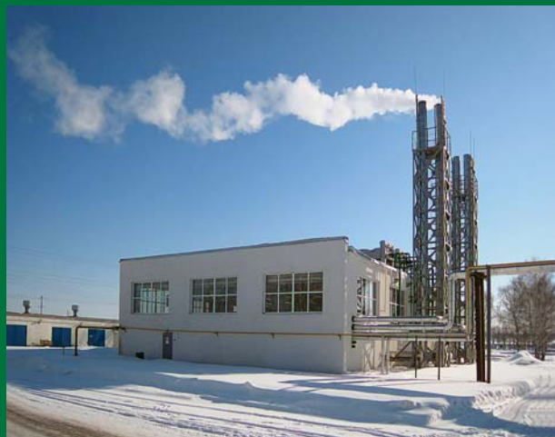
Мини-ТЭС завода «Авиакор-Железобетон»
